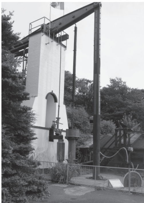
Rys. 6. Pompa parowa w kopalni Poldark. Fot. autora
